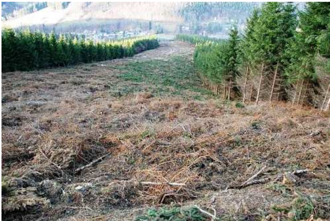
Foto 1: Pohled ze svahu od vrcholu Mravenečník na vykácený les v počátku výstavby Ski areálu Kouty nad Desnou
