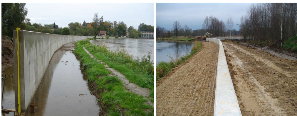
Obr. 26, 27: Hráz v průběhu stavby (zdroj: pla.cz [online], 2011-2-16)
