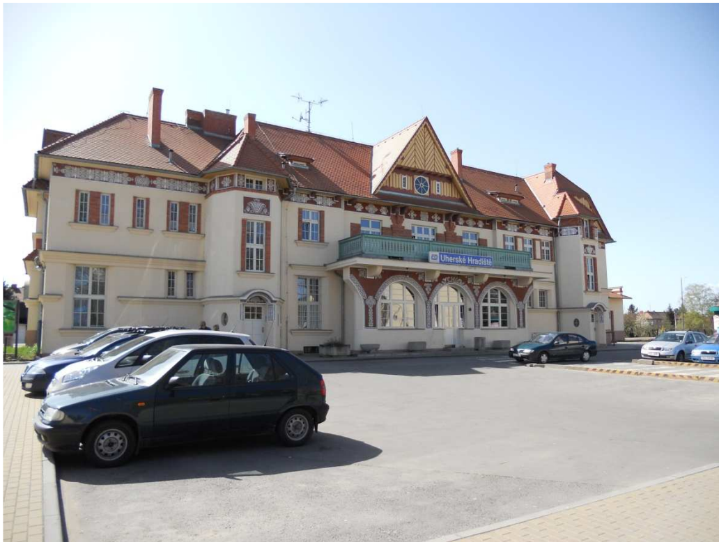
Obr. 1 Hlavní budova železniční stanice Uherské Hradiště
