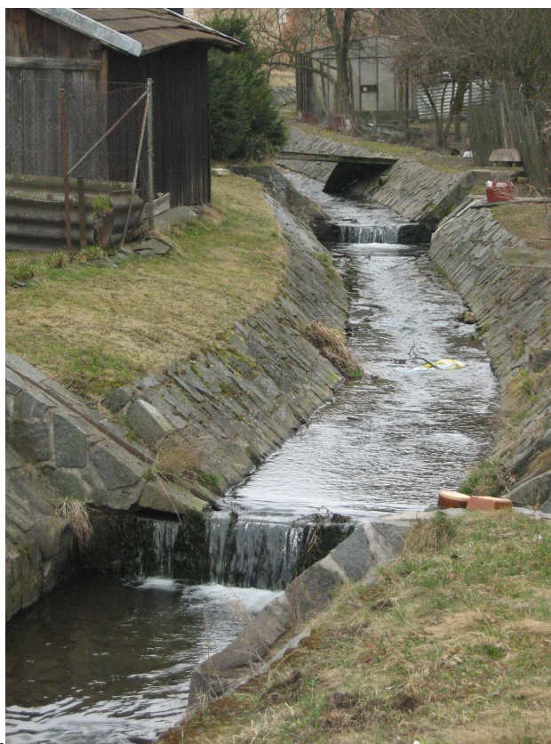
Obr. 13: Upravené koryto Mrákotínského potoka (foto: A. Tvrzická, 20. 3. 2011)
