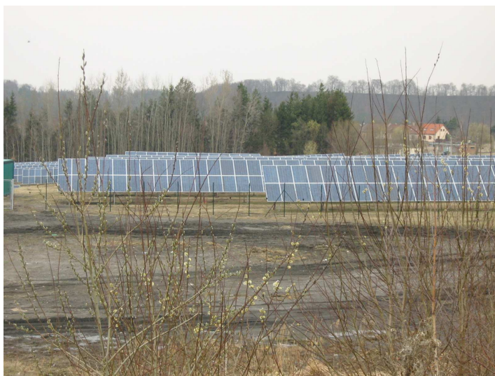
Obr. 14: Fotovoltaická elektrárna ve Skutči (foto: A. Tvrzická, 20. 3. 2011)
