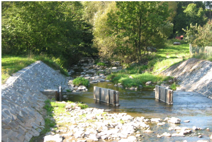
Obr. 12: Otevřený karetkový jez v obci Leštinka na vodním toku Žejbro (foto: A. Tvrzická, 23. 3. 2007)
