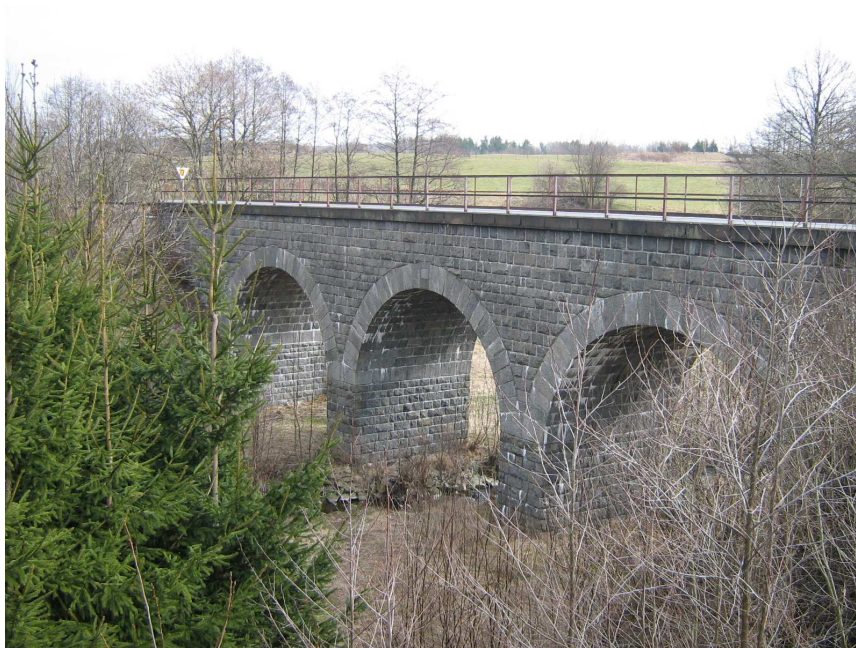
Obr. 8: Železniční most u Pokřikova (foto: A. Tvrzická, 20. 3. 2011)
