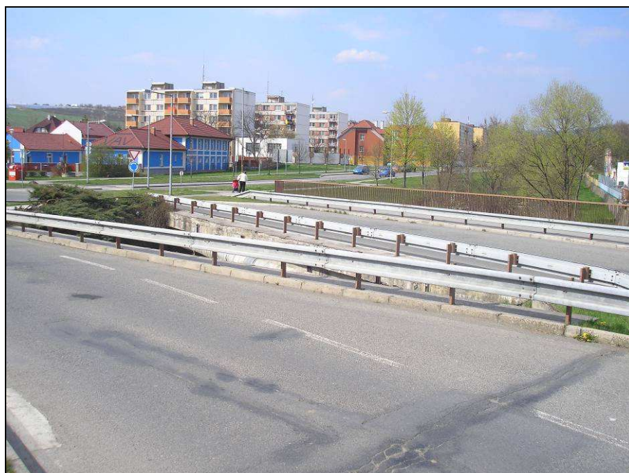
Obrázek H: Dva mosty ve Slušovicích postavené za 16 dní z roku 1982, v pozadí panelová zástavba z 80. let
