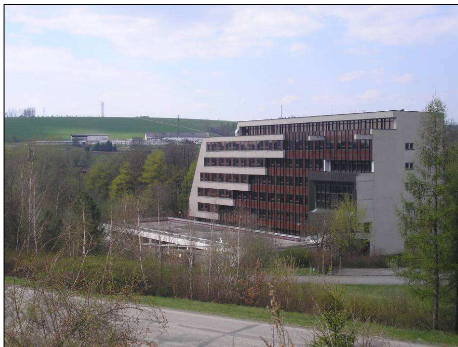
Obrázek G: Nová administrativní budova JZD Slušovice za dostihovou dráhou ve Slušovicích
