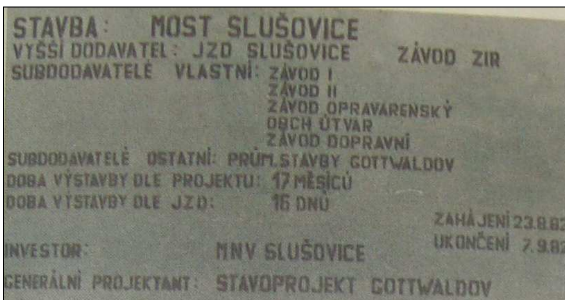
Obrázek 2: Cedule u výstavby mostu přes řeku Dřevnici ve Slušovicích (Zdroj: Naše cesta, 1982/37)
