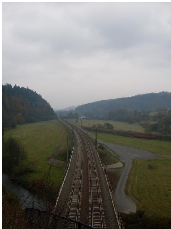
Obr. 22 Pohled do údolí od východního porálu tunelu Hněvkov (L. Paščenko - Březen 2011)
