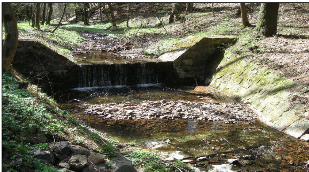
Obrázek 13: Akumulace suťového materiálu ve vývařišti malého jezu na Klučné (foto: autor, 11.4.2001)
