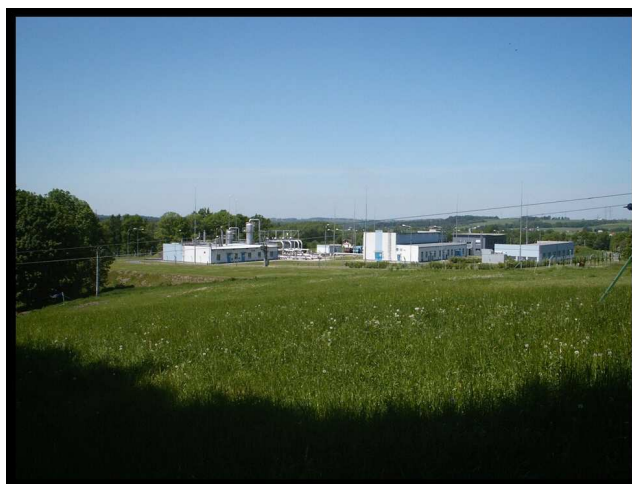
Obrázek 6.2-3:Centrální areál podzemního zásobníku plynu.
