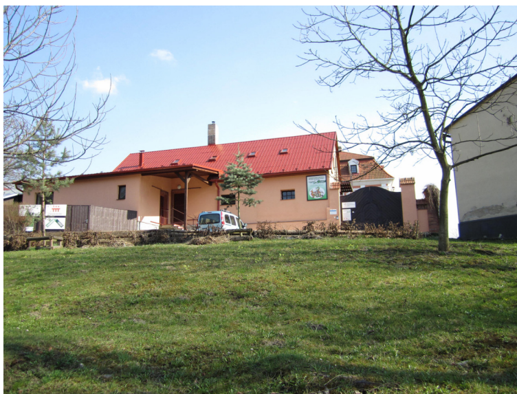
Obr. 10 Záchraná stanice v Bartošovicích (Hodanová, I., 03.04.2011)
