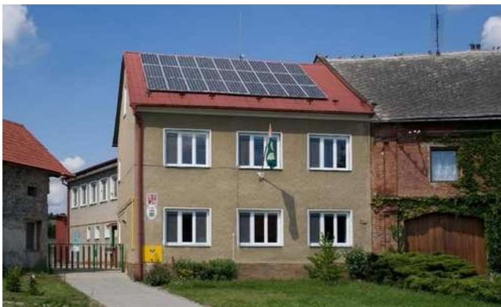
Obr. 24 Fotovoltaická elektrárna na budově mateřské školy v Bukovanech Zdroj: http://www.calla.cz – atlas obnovitelných zdrojů energie
