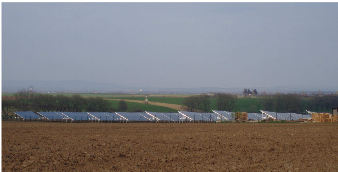
Obr. 20 Fotovoltaická elektrárna II v obci Určice
