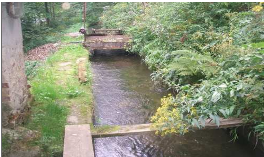
Obr. 27 Náhon malé vodní elektrárny v obci Branná Zdroj: http://calla.cz – atlas obnovitelných zdrojů energie
