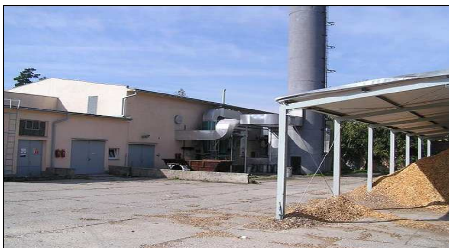
Obr. 28 Centrální výtopna ve Zlatých Horách Zdroj: http://www.calla.cz – atlas obnovitelných zdrojů energie
