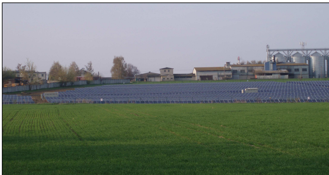
Obr. 19 Sluneční elektrárna I v obci Určice
