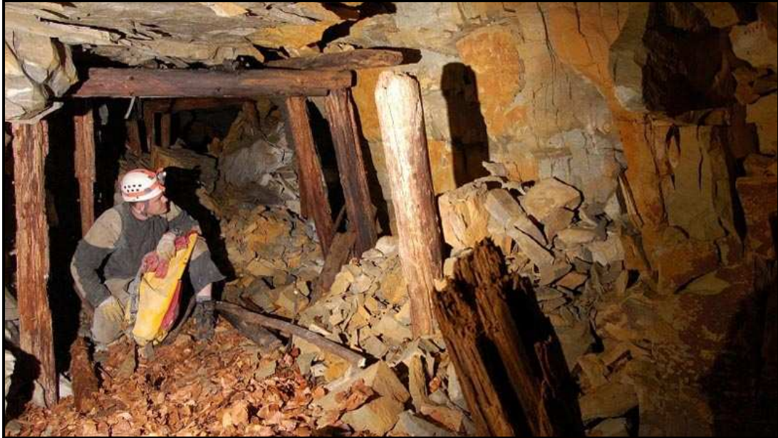
Obr. 10 Silné navětrání opuky v nitru štolý č. 1
