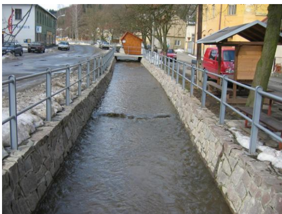
Obr. 12: Obdélníkový průtočný profil. (5.)
