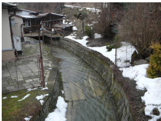
Obr. 8: Opevnění břehů lomovým kamenem do betonového lože a vydlážděné dno. (1.)
