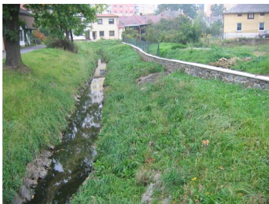
Obr. 22: Upravené koryto řeky Svitavy s ochrannou zídskou, Svitavy Lány 09/2007. (5.)
