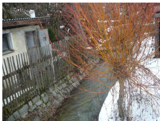
Obr. 5: Břeh zpevněný rovnáninou z lomového kamene. (4.)
