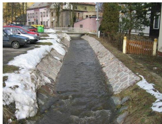
Obr. 13: Lichoběžníkový průtočný profil. (5.)
