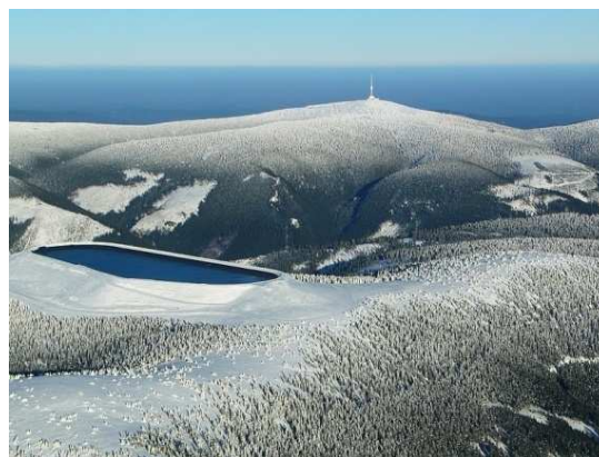
obr. 28. Elektrárna Dlouhé Stráně
