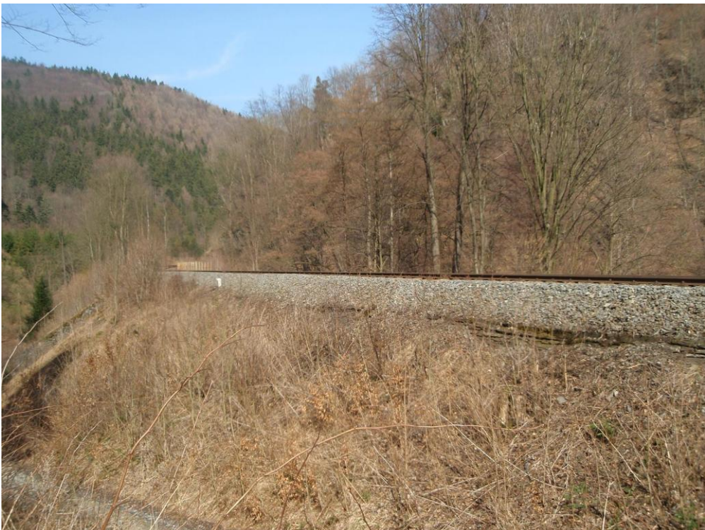
Obr. č. 23: Komunikační násep železniční trati Olomouc – Krnov u Jívové (Foto: M. Matoušová, 26.3. 2010)
