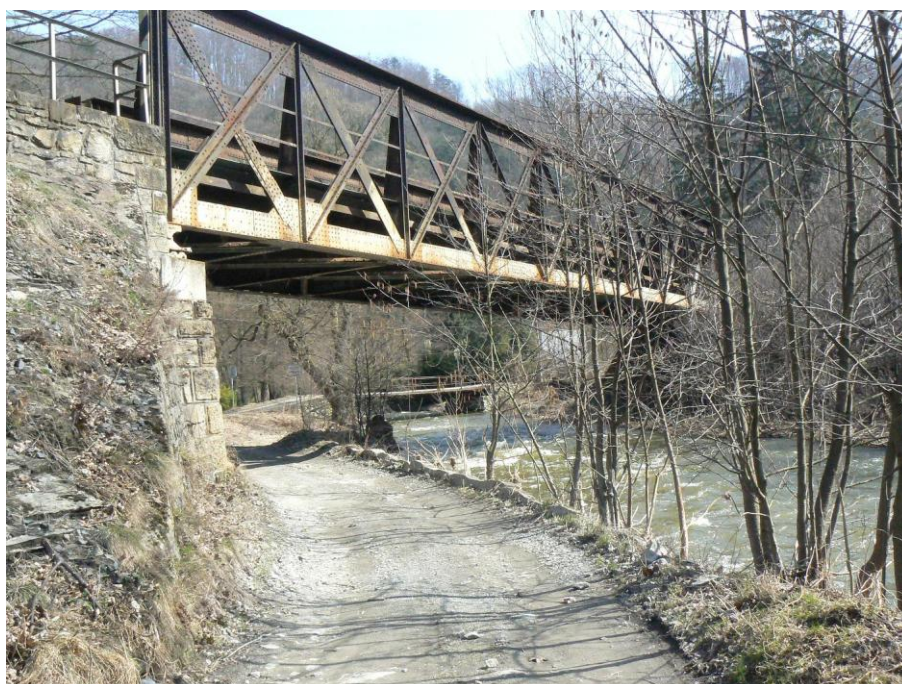
Obr. č. 25: Mosty přes řeku Bystřici u Hrubé Vody (Foto: M. Matoušová, 26.3. 2010)
