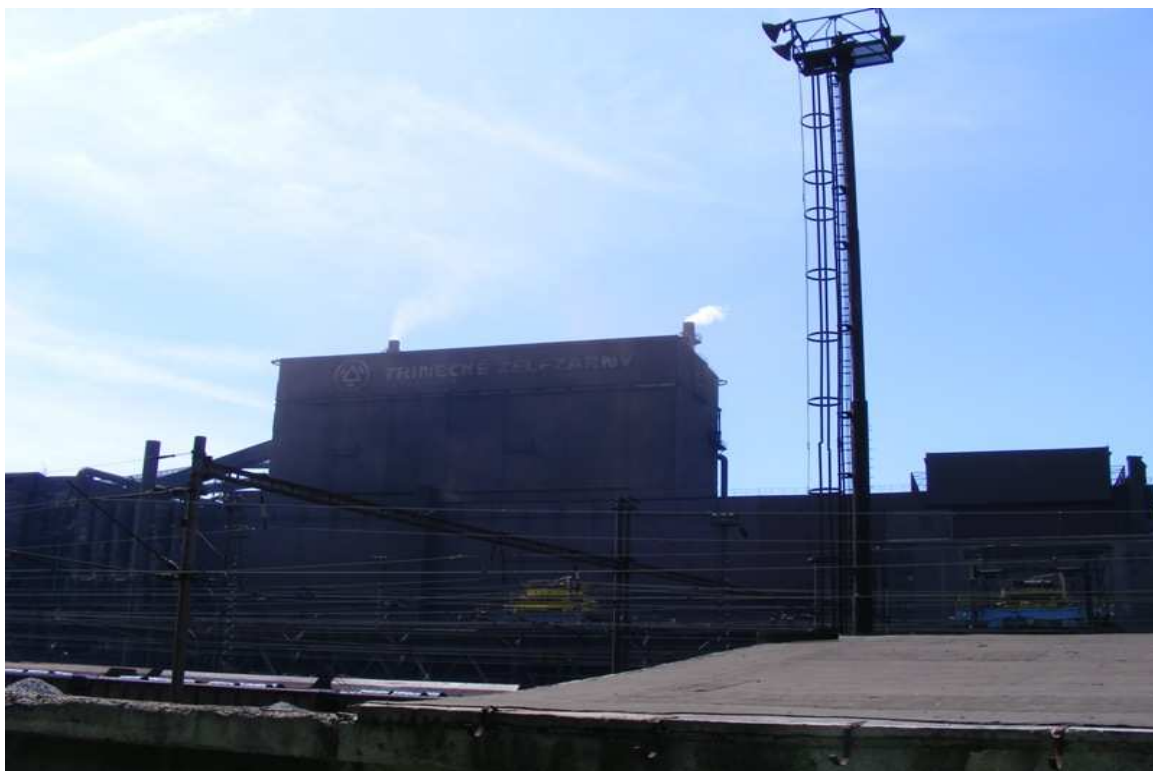
Obr. 1.5 Třinecké železářny, a. s. – budova hlavního provozu (Foto D. Lysková, 22. 7. 2009)
