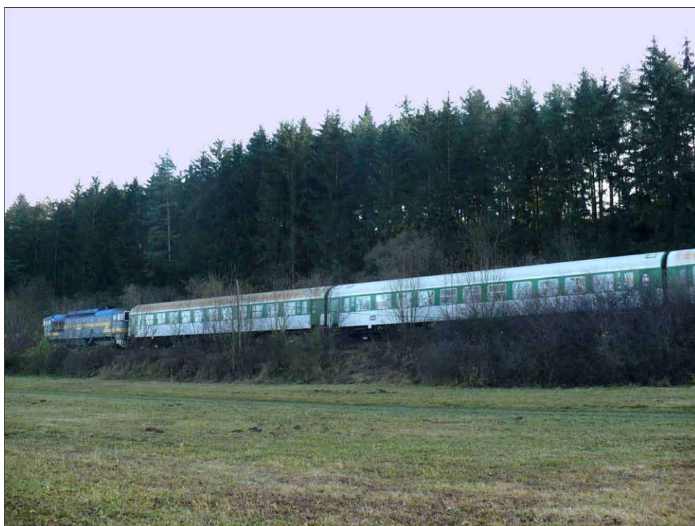
Obr. 26 Železniční násep v údolní nivě východně od Třebíče (Hana Láníková, 15. 11. 2009)
