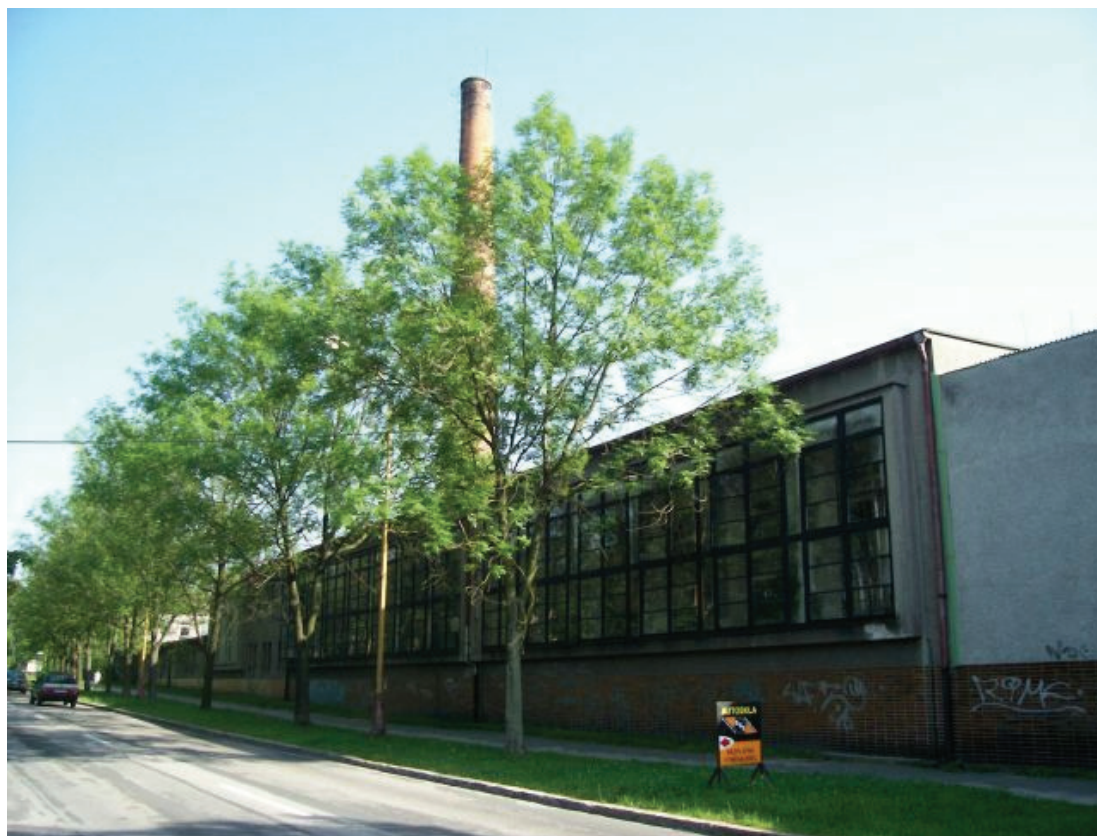
Obr. 1.10 Budova Dalkia ČR, a.s. v areálu nemocnice (foto P. Kokoruda)
