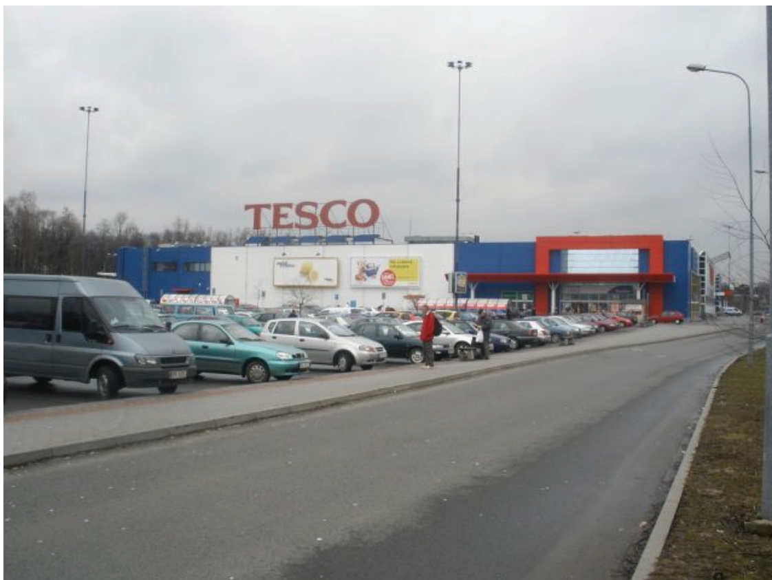
Obr. 1.8 Dry Clean, s.r.o. - Tesco Havířov – ekočistírna (foto P. Kokoruda)
