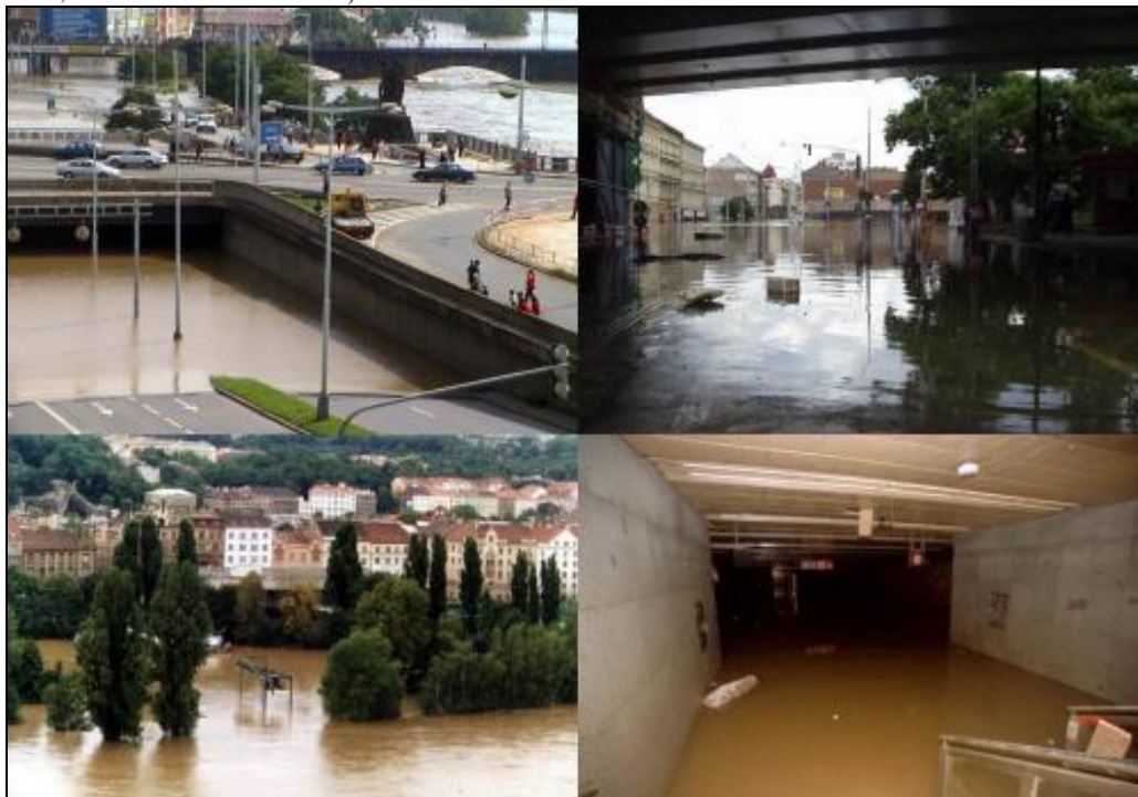
Obr. 4: Části Prahy při povodni roku 2002 (nahore zleva Argentinská ulice, Karlín, dole zleva Císařská louka, metro-nádraží Holešovice)
