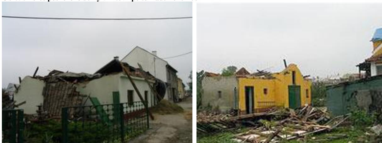
Obr. 9: Těžce poškozené domy v Litovli po tornádu roku 2004
