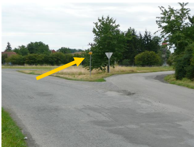
Obr. 5.89: Nevhodné umístění směrové tabulky u Bohuňovic (foto: Š. Krbcová, 13.8.2008)
