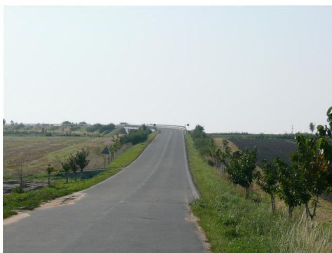
Obr. 5.6: Silnice III. třídy z Velké Bystřice v blízkosti nadjezdu nad rychlostní komunikací R35 (foto: Š. Krbcová, 18.8.2008)
