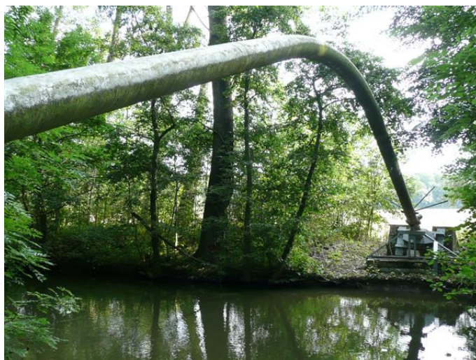
Obr. 5.25: Přemostění zemního plynu přes Mlýnský potok (foto: Š. Krbcová, 30.7.2008)
