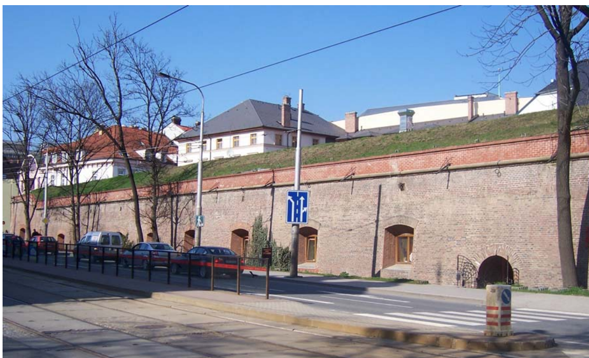
Obr. 12: Čelní strana kasematního valu Vodních kasáren (stav po opravě)
