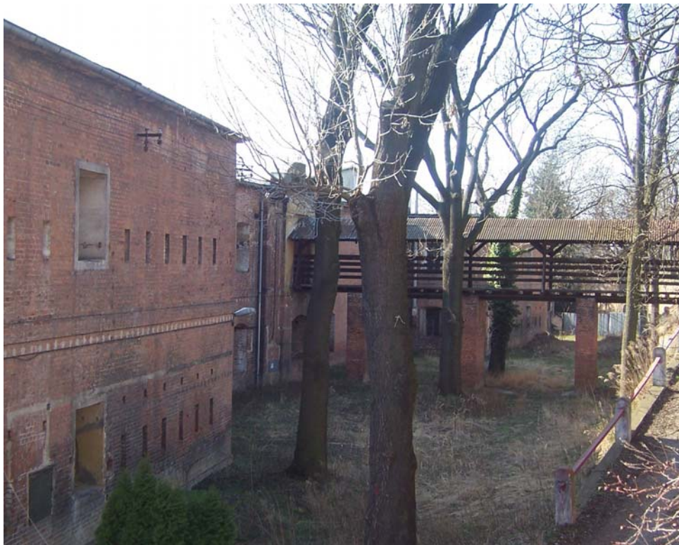
Obr. 20: Pohled na most přes šijový příkop spojující horní podlaží reduitu s kontreskarpou
