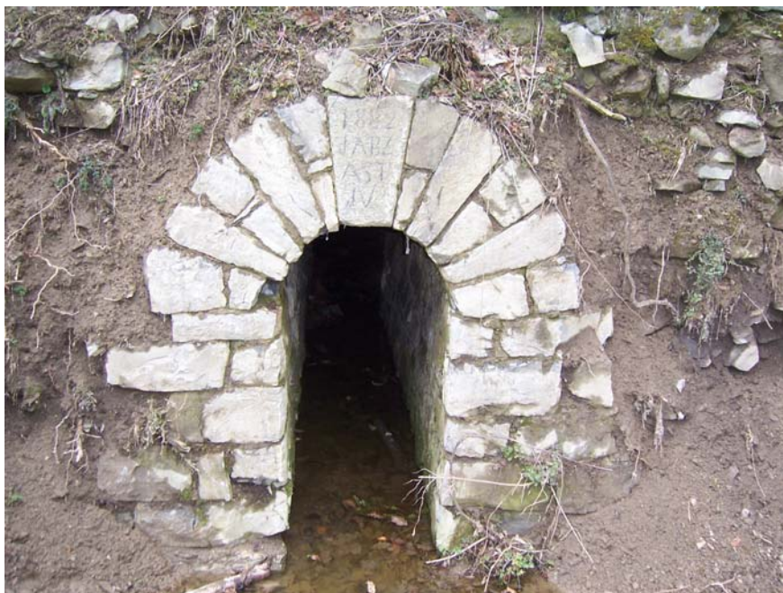
Obr. 25: Odvodňovací štola fortu Radíkov 2
