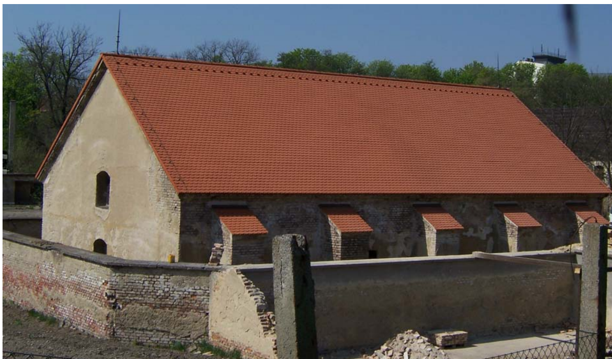
Obr. 15: Prachárna ( po rekonstrukci střechy)
