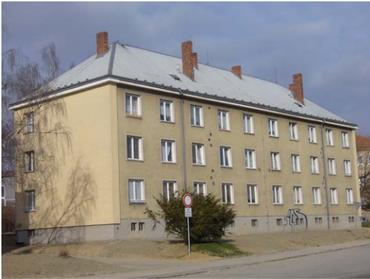
13. Sídliště Stalingrad, bytové domy z (50. léta)
