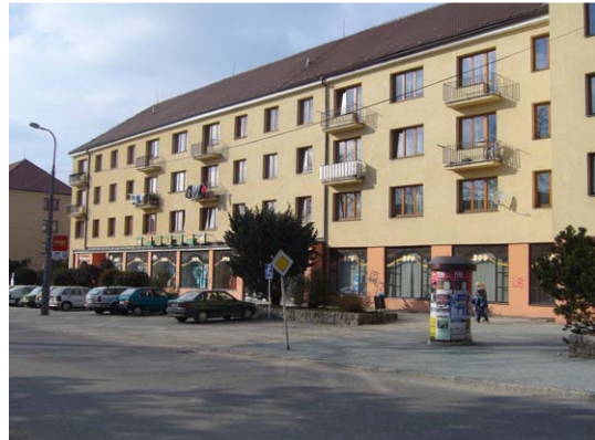
12. Sídliště Stalingrad, zrekonstruované bytové domy (50. léta) v přízemí obchody
