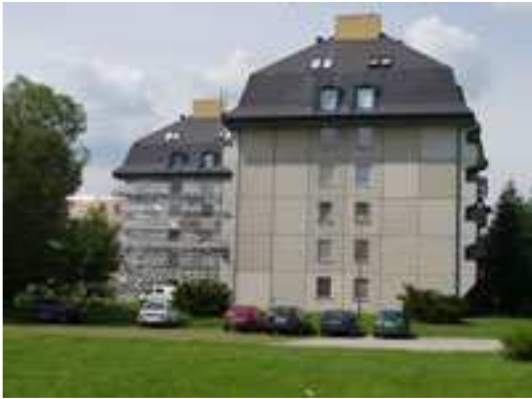
19. Půdní nadstavba na Purkyňově ulici (80 - 90. léta)
