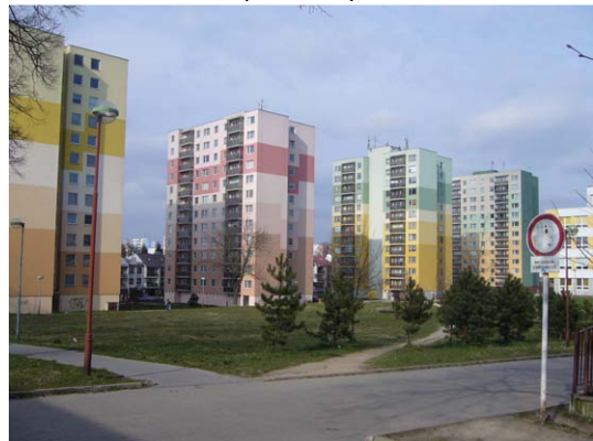
18. Panelová výstavba, Palachova ulice, sídliště U nádraží (80. léta)
