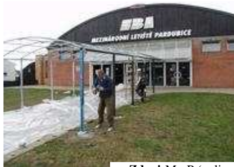
Obr. 5.2.1.18 Odbavovací hala letiště
