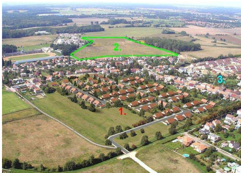
Obr. 5.2.1.11 Výstavba v lokalitě Svítkov (1. realizovaná, 2. plánovaná, 3. již zrealizovaná)
