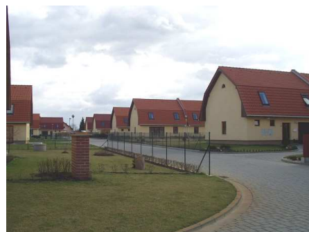
Obr. 5.2.2.2 Výstavba v Obci Srnojedy
