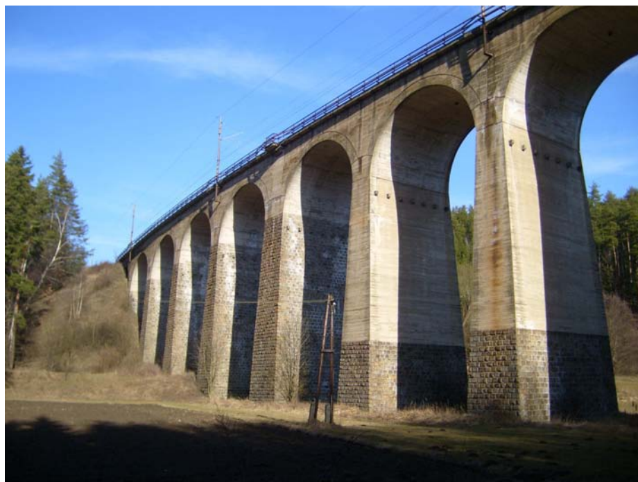
Obr. 18: Železniční most přes údolí Libochůvky severozápadně od Kutin
