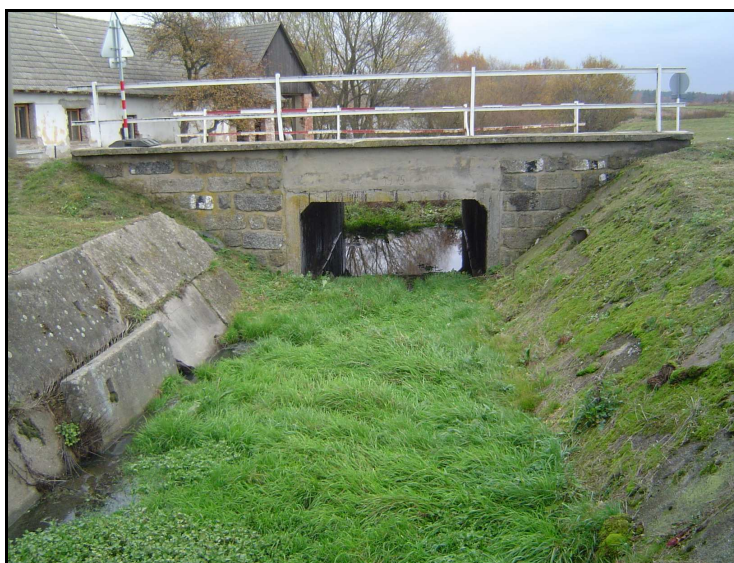
Obr. 21: Regulované koryto toku v obci Vlkov (foto: R. Marková, 3. 11. 2007)
