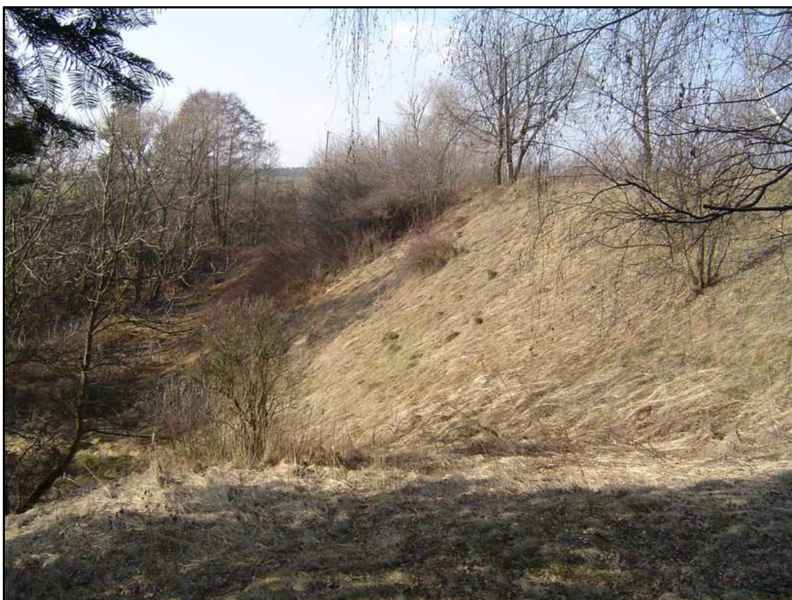
Obr. 23: Vzdušný svah hráze Vlkovského rybníka (foto: R. Marková, 28. 2. 2008)
