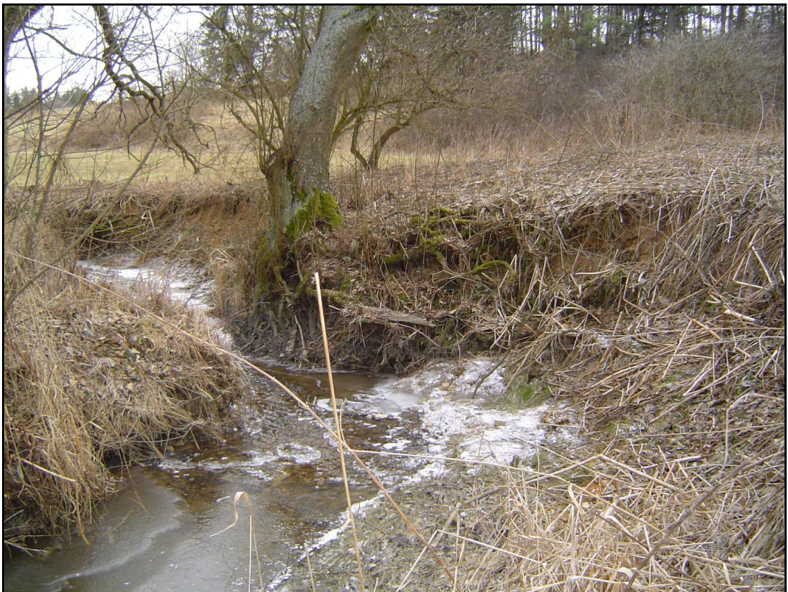
Obr. 9: Břehové nátrže na Bílém potoce (foto: R. Marková, 28. 2. 2008)
