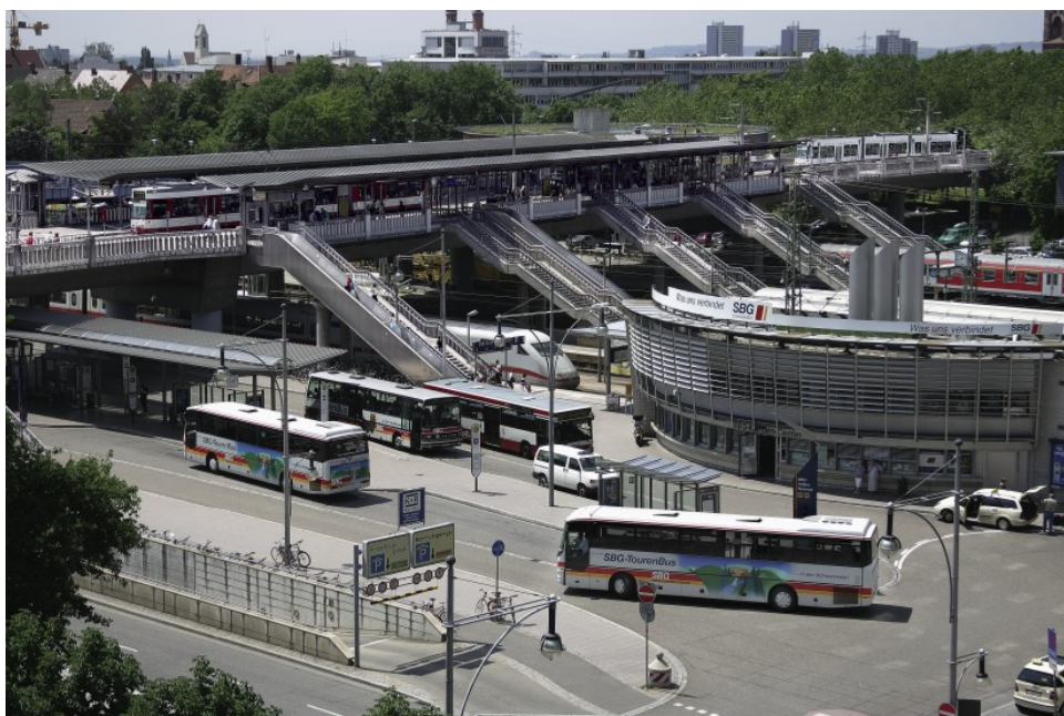
Obr. 5: Terminál veřejné osobní dopravy ve Freiburgu (zdroj: regio-verbund.de)
