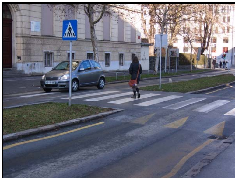
Obr. 24: Vyvýšená úprava přechodu pro chodce na Gosposvetske ulici (foto: Hercik, 2008)
