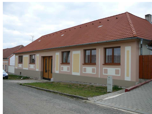
Obr. 54: Opravená usedlost v Lovčovicích
