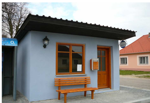
Obr. 48: Autobusová zastávka v Lovčovicích
