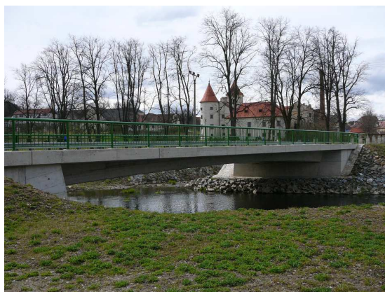
Obr. 49: Nový most přes řeku Dyji v Písečném
