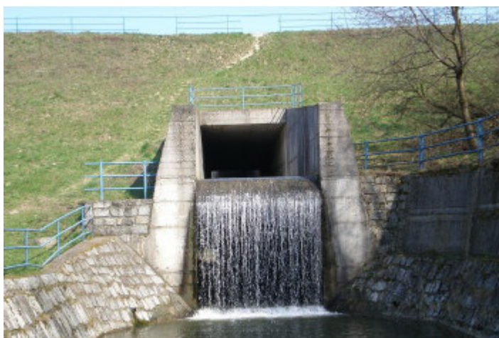
FOTO 5: Průtok pod nádrží v Tršicích (J. Vodičková, březen 2007)
