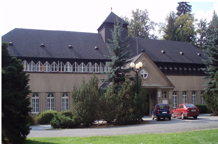
Obr.22: Hlavní lázeňská budova Zdroj: Vlastní sbírka
