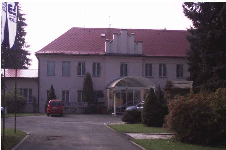
Obr.1: Hlavní lázeňská budova Zdroj: Vlastní sbírka
