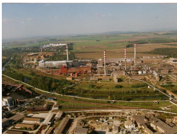
Obr.11: Areál Chemických závodů v Přerově.
