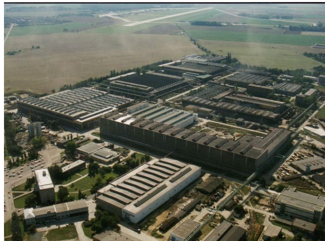
Obr.3.: Haly podniku Přerovské strojírný v Přerově
