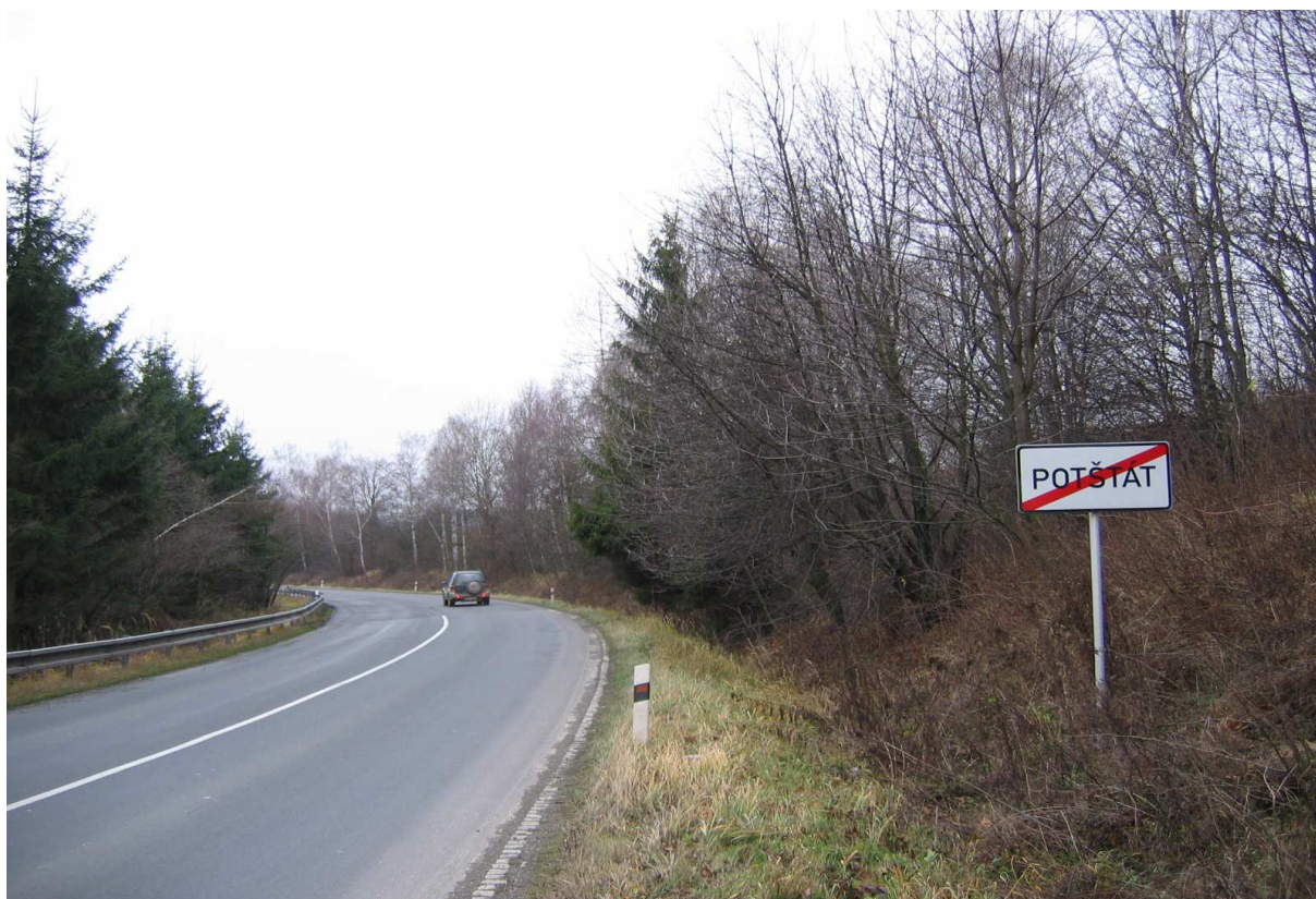
Foto 14 Úsek č.7 – Boškov - Potštát - pohled směrem z Potštátu na Boškov (autor: Svobodová 2006)
