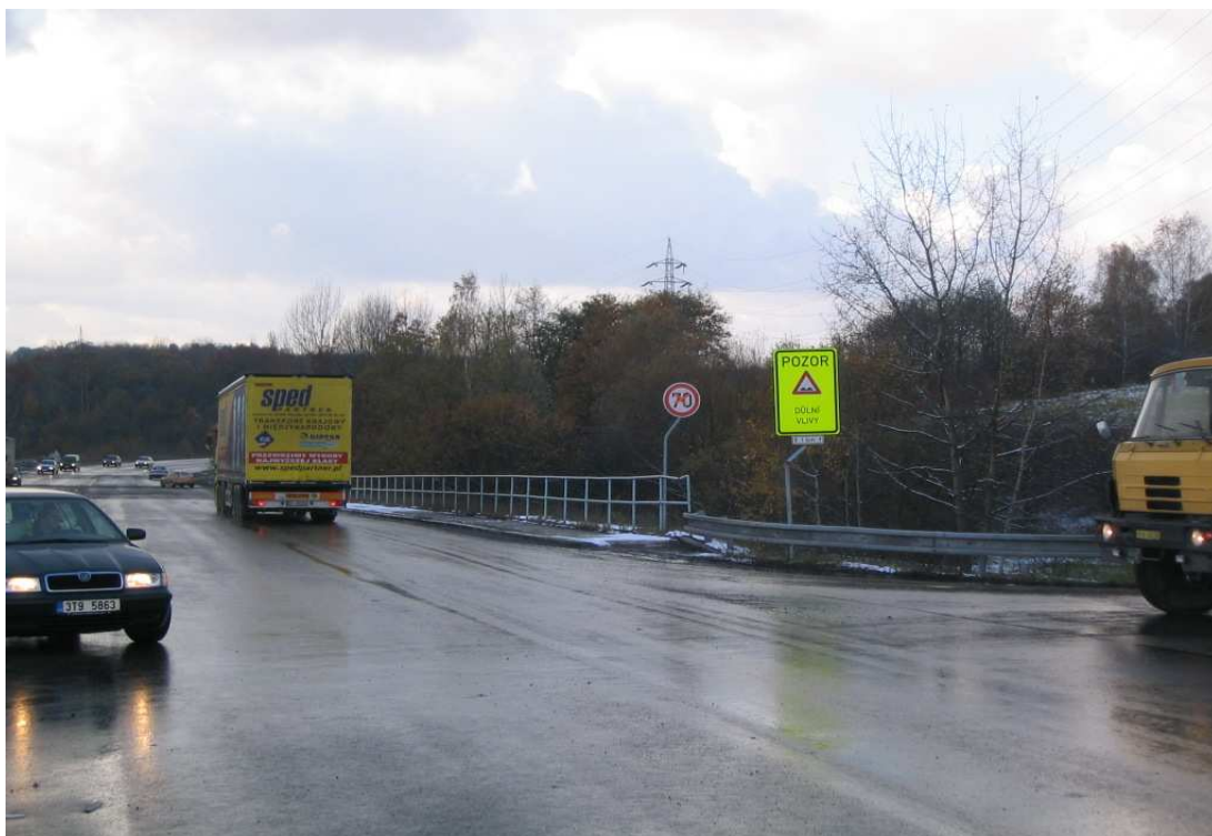
Foto 2 Úsek č.1 – Karviná – Doly - pohled směrem od Ostravy (autor: Svobodová 2006)
