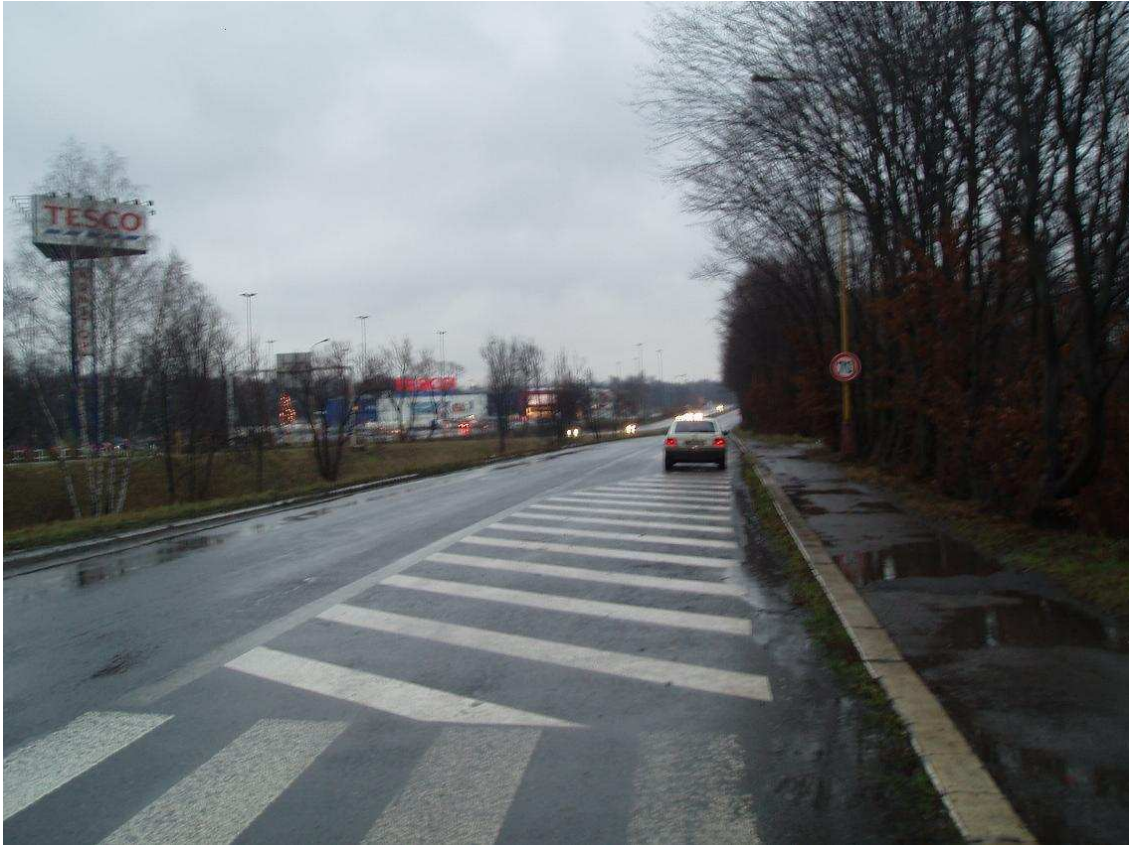
Foto 3 Úsek č.2 – Havířov – Prostřední Suchá 1 – pohled směrem od Ostravy (autor: Svobodová 2006)
