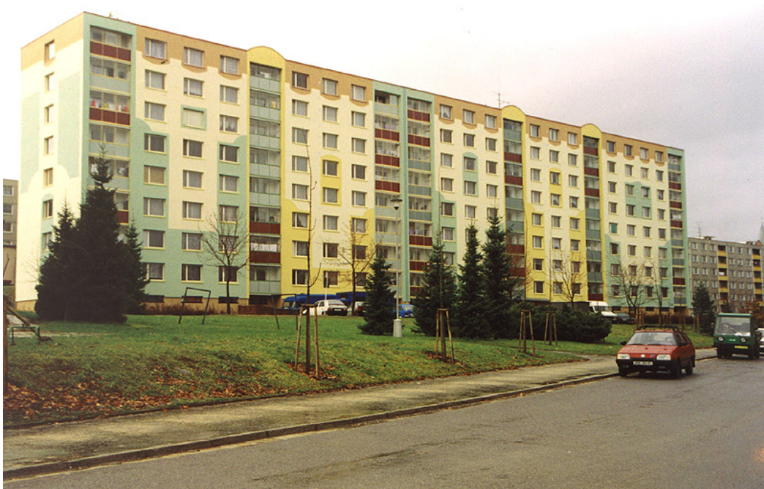
Obr. 3: Panelový dům před a po revitalizaci (zdroj: www.svitavy.cz )
