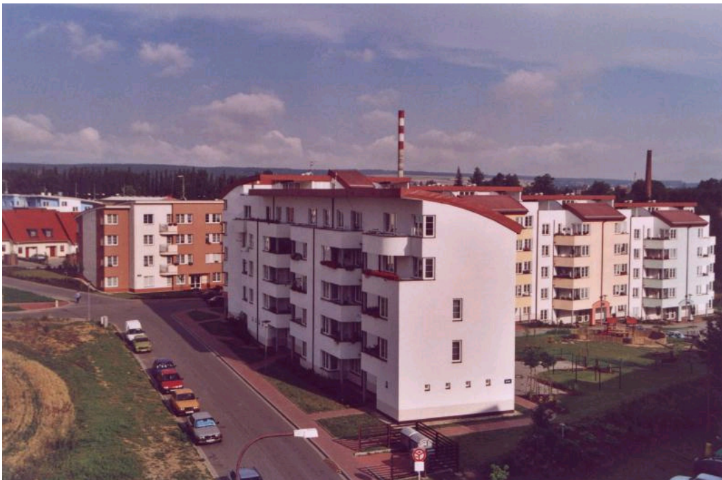
Obr. 4: Bytové domy v lokalitě na Věžíři ve Svitavách (zdroj: www.svitavy.cz )
