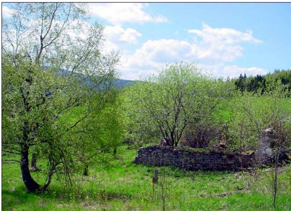
Foto 9 Ruina jednoho z bývalých domů. (Převzato z: Rychleby – Hraničky [online]. c2001 – 2005 [cit. 2006-08-01]. Dostupné z: http://www.rychleby.cz/Mistopis/mistopis.html )
