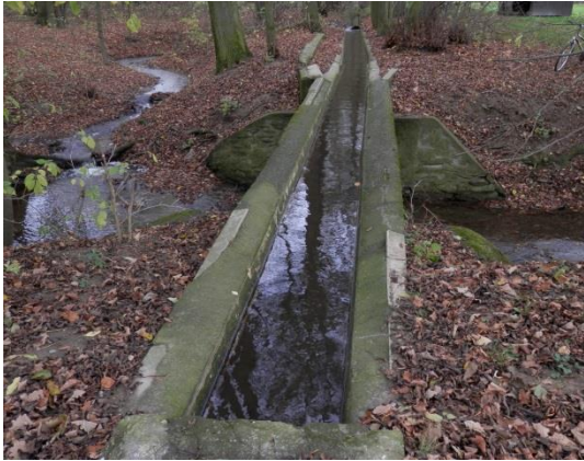
Foto 20: Akvadukt přes Tepličku v S části Haukovic (Mašková, 2013)
