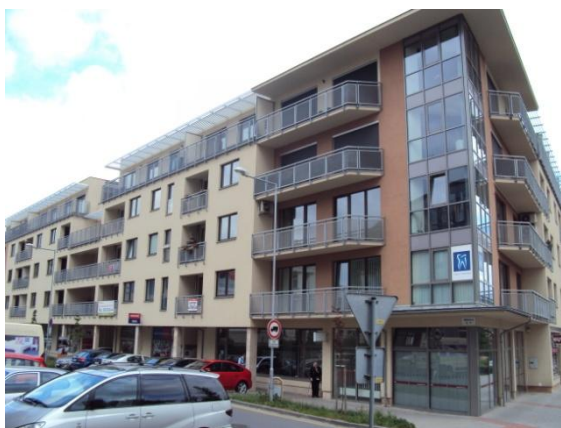
Obr. 24: Polyfunkční dům Top house Wellnerova
