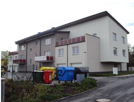
Obr. 16: Bytový dům Olomouc – Balcárkova
