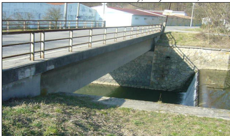
Obr. 13: Mostní konstrukce a jez v Lípě, zdroj: Jakubová, 2014
