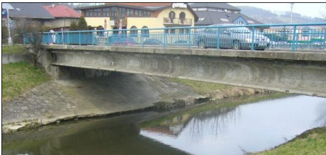
Obr. 12: Mostní konstrukce v oblasti Zlín – Příluky, zdroj: Jakubová, 2014
