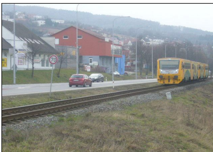
Příloha 7: Komunikační násep (železniční a silniční - I/49), zdroj: Jakubová, 2014
