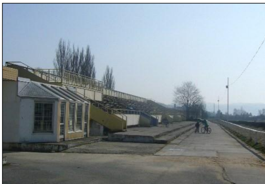
Obr. 15: Pohled současně zchátralé tribuny v areálu dostihové dráhy, zdroj: Jakubová, 2014
