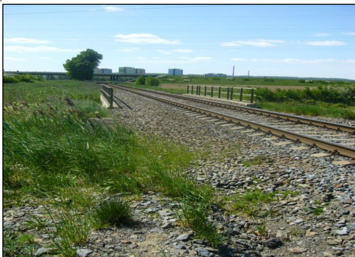
Příloha 6: Železniční násep tratě Otrokovice – Zlín – Vizovice, zdroj: Jakubová, 2014
