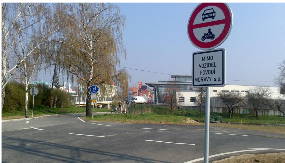
Obr 29. Zde začíná smíšená stezka při Baťově kanálu podjezdem pod silničním mostem přes Baťův kanál. Jižním směrem (na fotce vpravo) se nově napojuje na novou komunikaci vybudovanou na protipovodňové hrázi (Haničinec, 2014).
