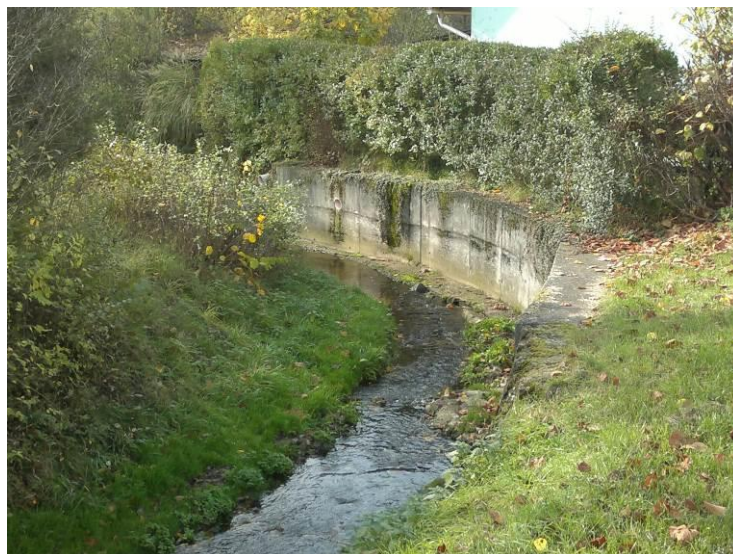
Obr. 3: Úprava koryta Březnice v Březnici
