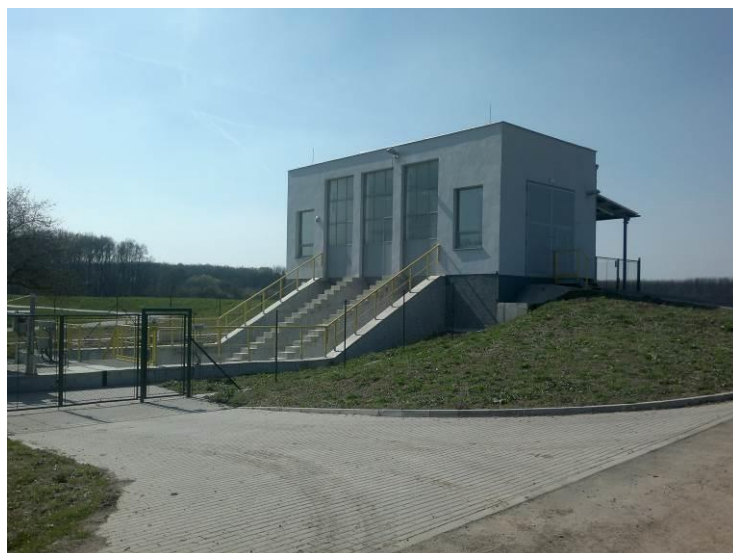
Obr. 15: Přečerpávací stanice v Kněžpoli
