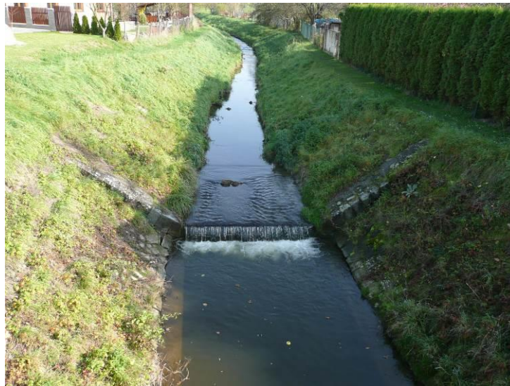
Obr. 8: Úprava koryta v Bílovicích
