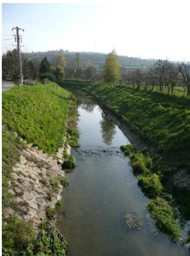
Obr. 11: Úprava koryta v Bílovicích
