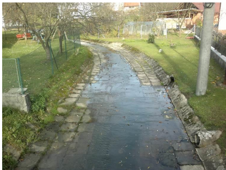
Obr. 4: Úprava koryta Březnice v Bohuslavicích u Zlína
