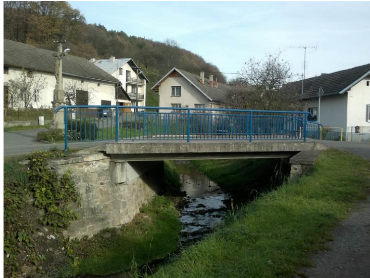
Obr. 1: Mostní konstrukce v Březnici
