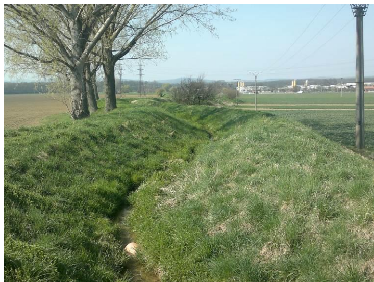
Obr. 18: Ochranné hráze Místřického potoka
