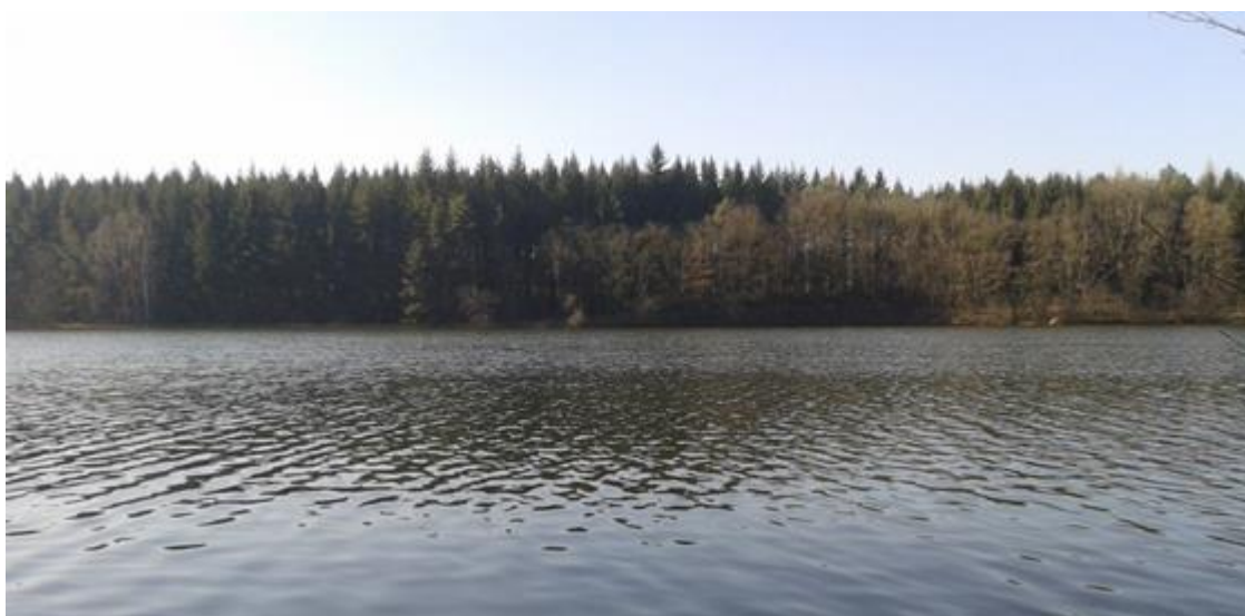
Obr. 13: Přehrada Vrchlice (Foto: Kácovská 12. 3. 2014)
