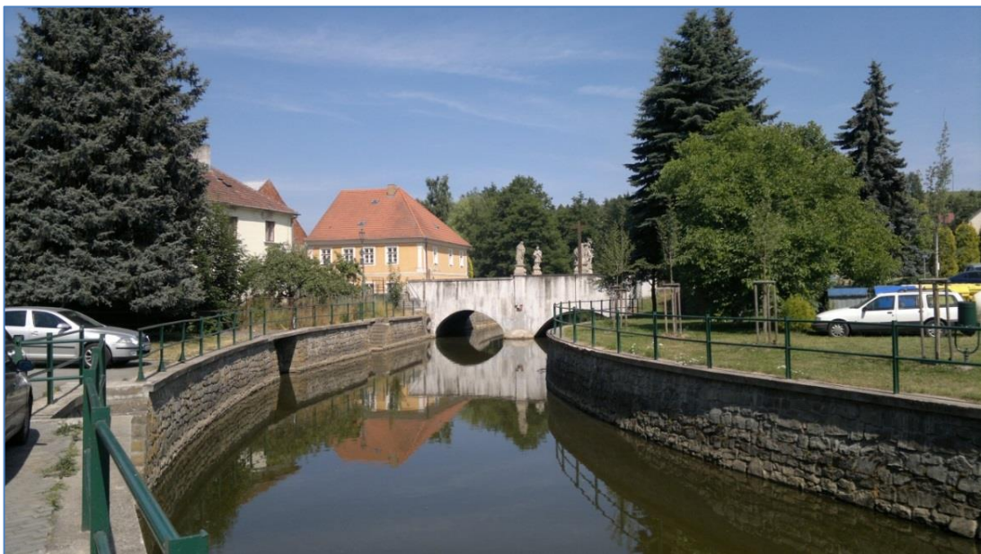
Obr 11: Zpevněné koryto řeky s Židovským mostem ve městě Brtnice (foto: Lenka Dočekalová, červenec 2013)
