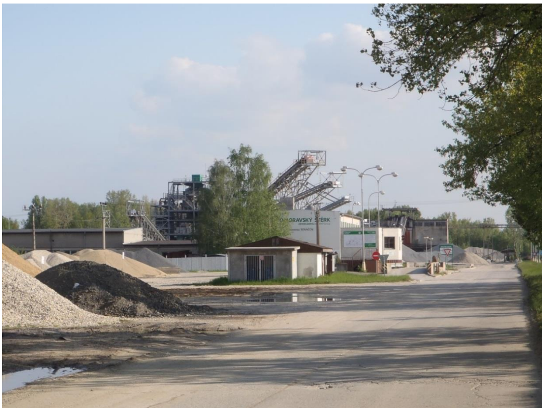
Obr. 12 Technické zázemí pískovny těžící na jezeře Donbas (foto: Anežka Brhlíková, 2014)
