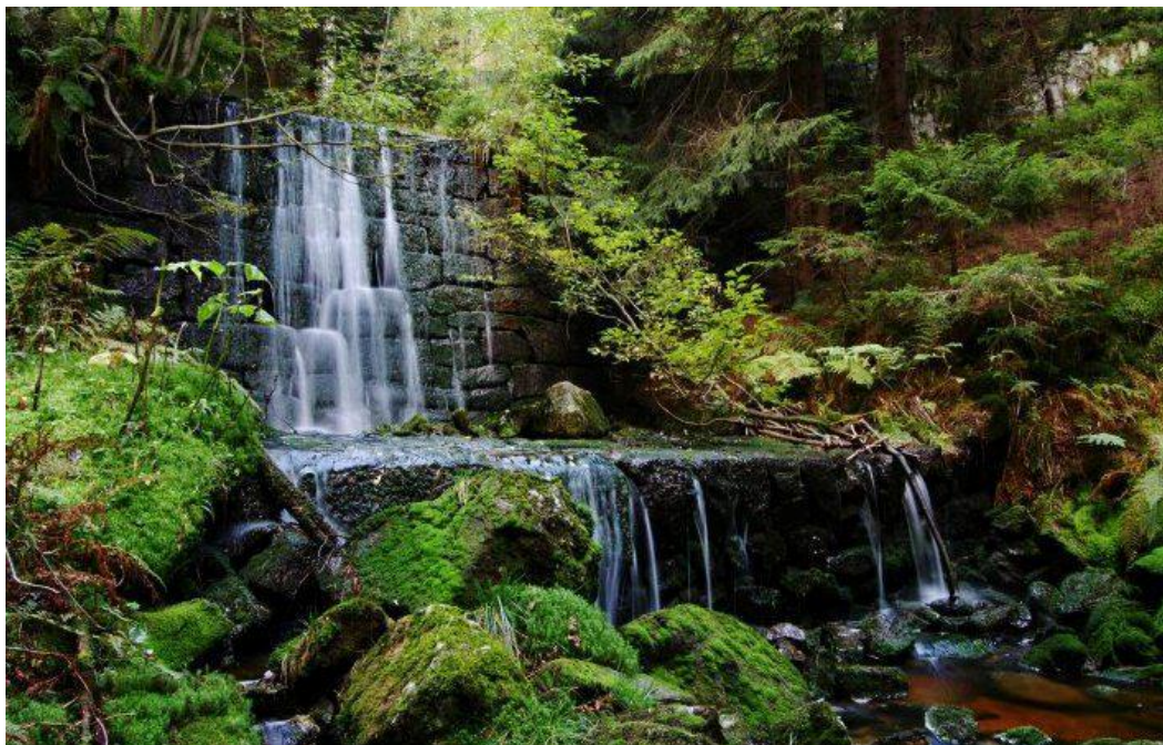
Obr. 6: Údolí Těsného dolu, na obrázku jsou zobrazeny malé přehrádky tzv. „klauzy“, které byly v minulosti využívány pro plavbu dřeva a pro snížení rychlosti vodního toku. Autor: Jan Trenčianský, 2012
