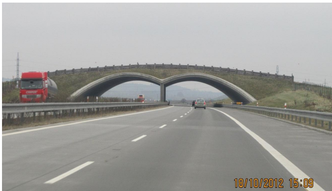
Obr. 5: Ekodukt na km 120,500 (Šustek, 2012).
