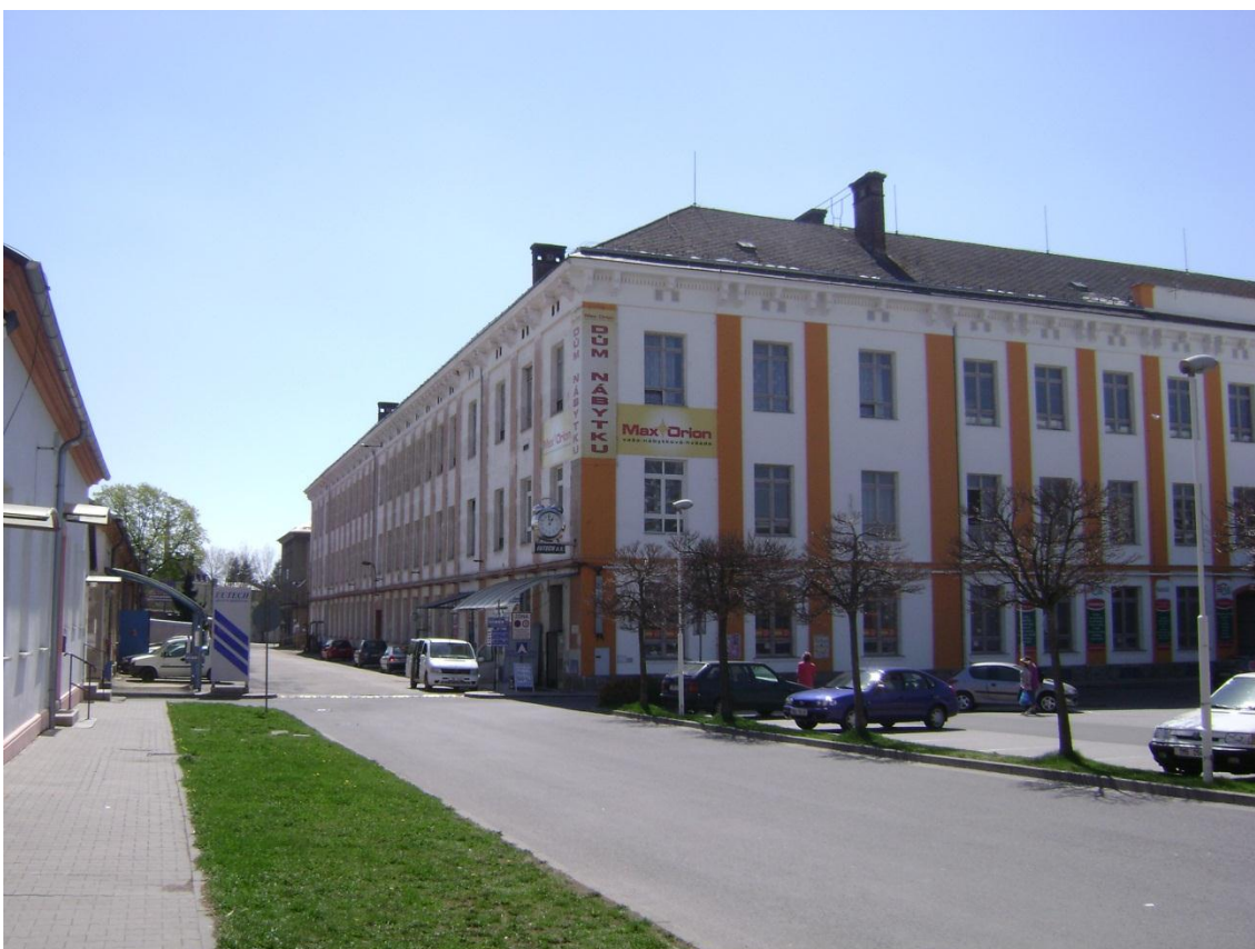
Příloha 5 – Budova firmy EUTECH a.s. – bývalá Chronotechna (Zdroj: vlastní sbírka, 2013)
