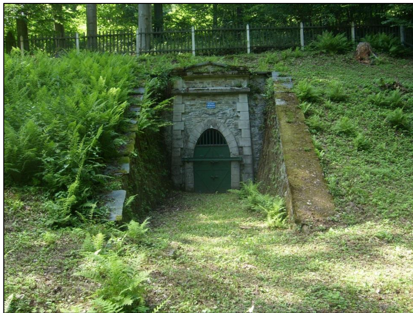
Obr. 16: Vstupní portál Levínské štoly v Lokalitě Chabičovsko (Milan Poláček, 2012)
