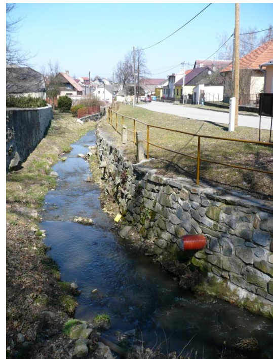
Obr. 4 - Puklický potok protékající sídlem Puklice; zdroj: vlastní foto
