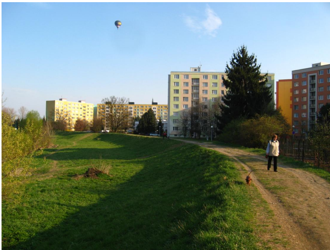
Obr. 18: Ochranné valy před povodněmi a panelové sídliště
