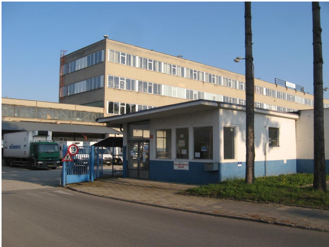
Obr. 16: Sklady (bývalý průmyslový areál Kovo-Dřevo)
