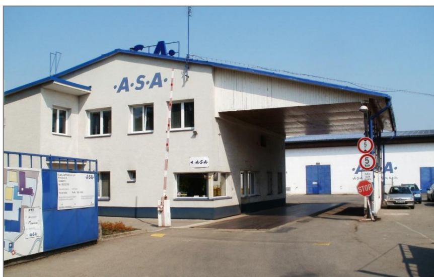
Obr. 4 Administrativní budova společnosti A.S.A (foto: B. Kalábová, 18.4 2013)
