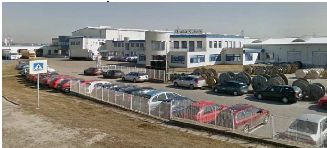
Obr. č. 13: Podnik Draka Kabely s.r.o.
