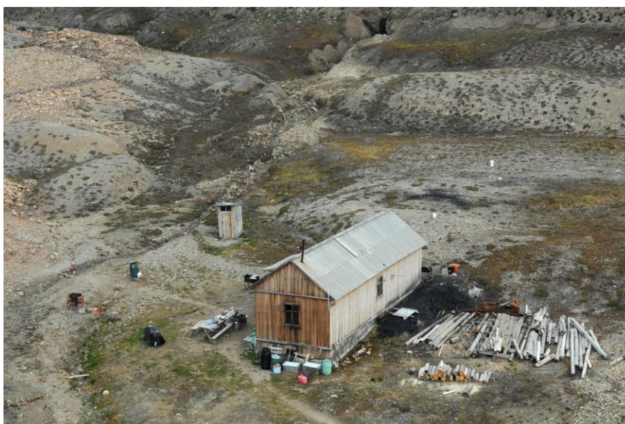
Obr. 4.1.1: Česká výzkumná stanice (Jan Kavan, 2012)
