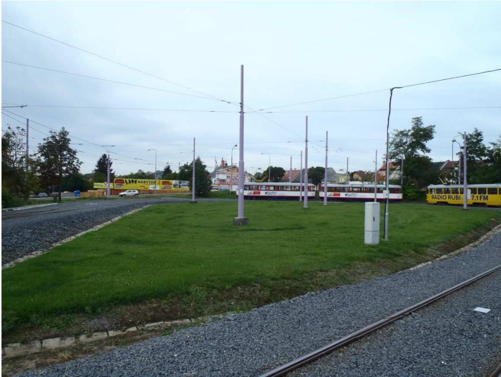
Foto 109: Ulice Hraniční, konečná stanice tramvají (05.10.2012)
