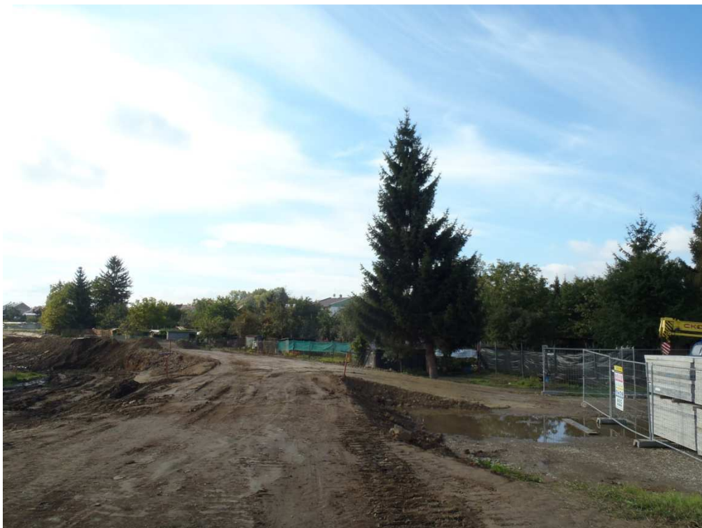
Foto 135: Střední novosadská, budování silnice u zahrádkářské osady (13.10.2012)
